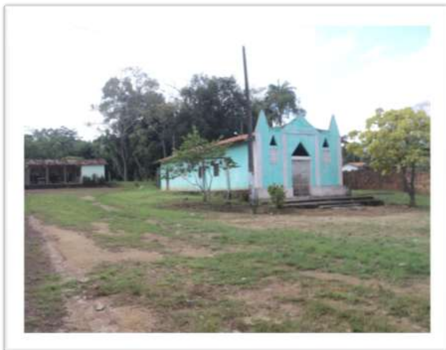
Figura 9: Igreja da comunidade de Lauro Sodré
