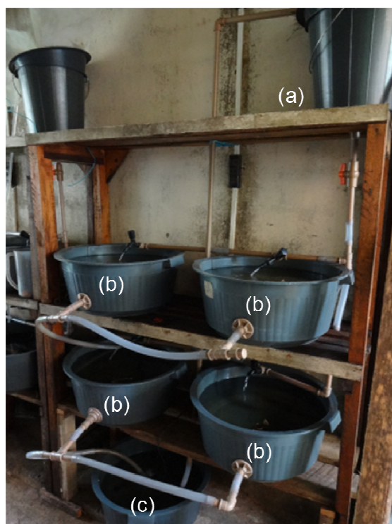
Figura 16: Sistema de recirculação de água para manutenção de P. vittata e S. aureatus em cativeiro. (a) Filtro físico-biológico: composto por telhas de barro e carvão ativado; (b) tanques; (c) área de recirculação com vazão de 2000 L/h. Imagem: Priscila Araújo.
