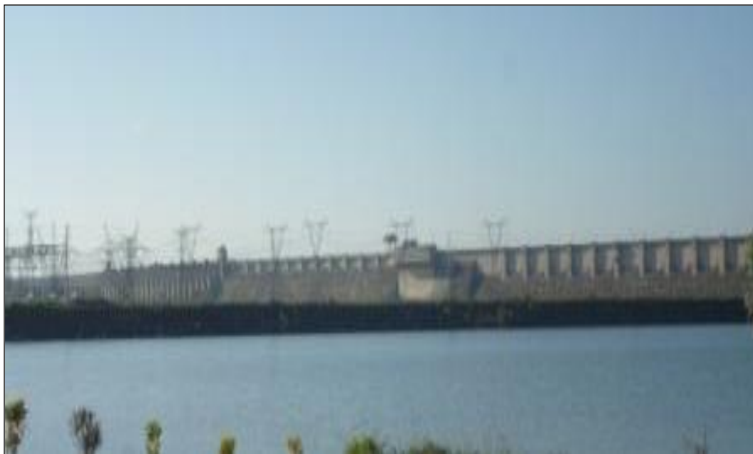
Fotografia 1 – Usina Hidrelétrica de Tucuruí – UHT.
