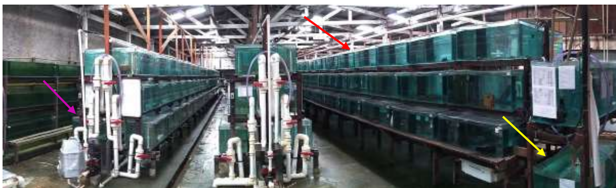
Figura 2 – Sistema de aquários da empresa Arapaima Brazil Ltda utilizados neste experimento. Seta vermelha, linha de sistema de aquários selecionada; Seta amarela, cisterna de captação de água; Seta rosa, sistema de circulação e filtragem de água.
